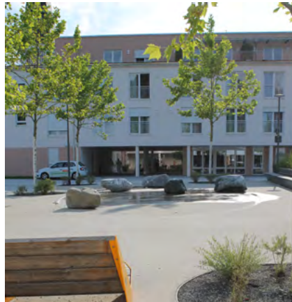
Abb. 270: Beispiel „Neue Mitte“ Altenstadt
