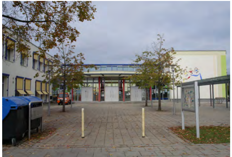
Abb. 252: Blick auf die Grundschule
