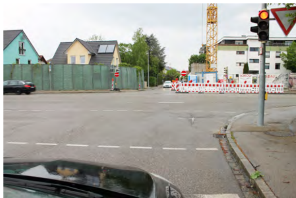
Abb. 314: Lärmschutzwand an der B2, Kreuzung Bahnhofstraße
