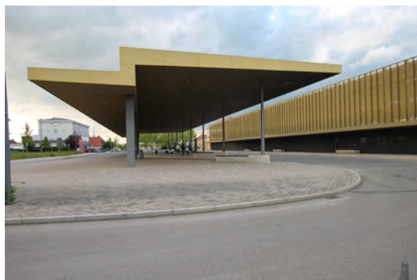
Abb. 265: Beispiel eines Bahnhofsvordachs aus der Stadt Nördlingen
