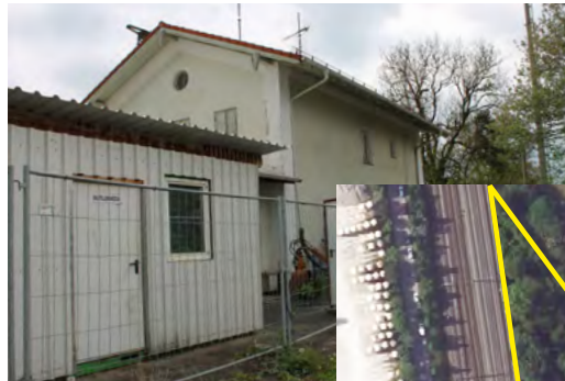
Abb. 273: Alter Bahnhof Kissing
